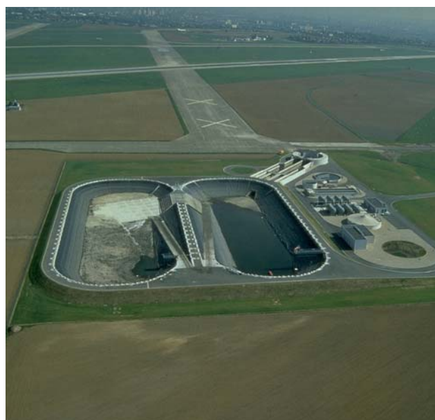
Installation de traitement des eaux pluviales à Orly.
